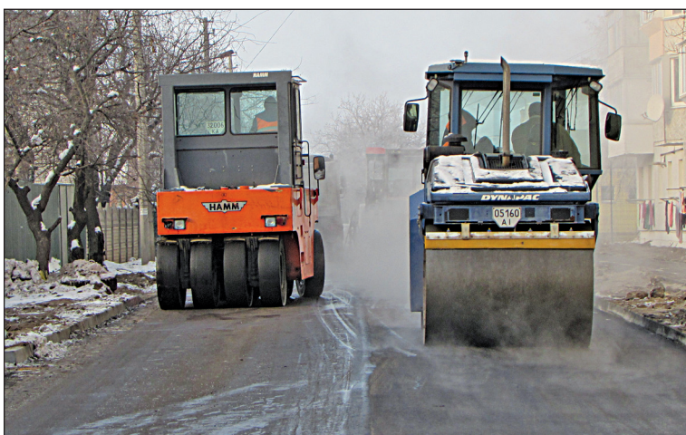
Фінальний акорд будівельників
